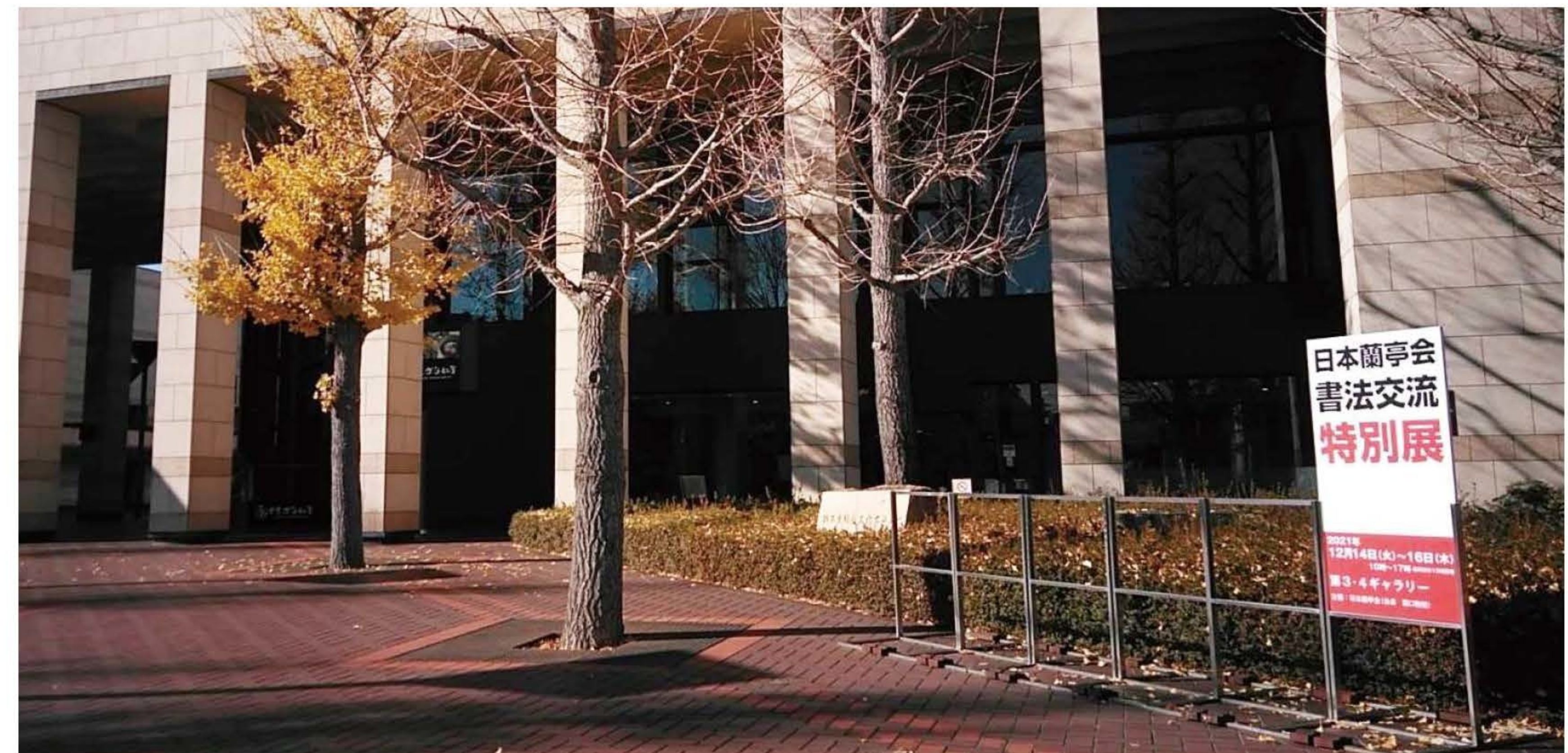
栃木県総合文化センター
